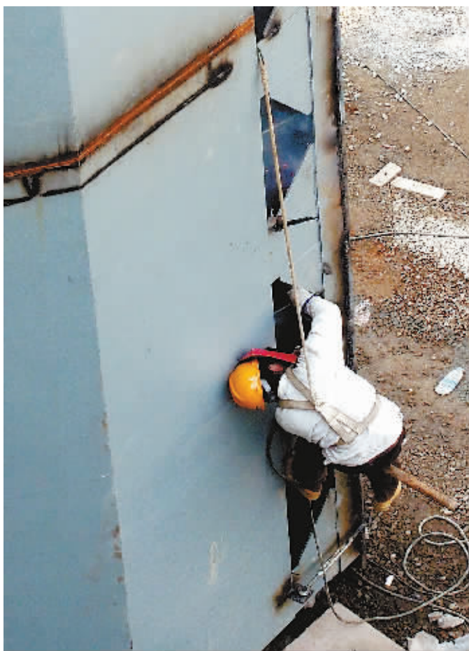
右图工人在闸下进行作业。本报记者 齐浩 摄
